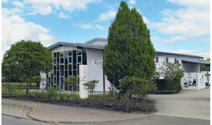
Ein modern konzipierter Gebäudekomplex in Gemünden ist seit 2016 Firmensitz der Activoris Medizintechnik GmbH.
